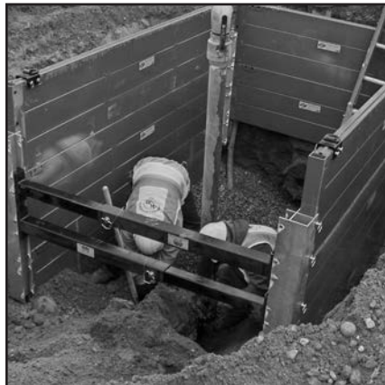
Configuration à trois côtés avec des supports télescopiques sans panneau en dessous
