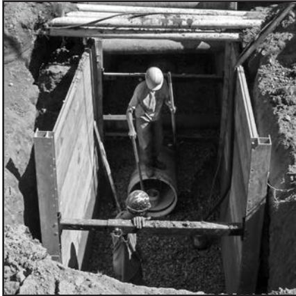
Configuration à deux côtés avec des supports télescopiques et des poteaux de coin à pleine longueur
