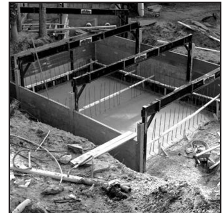
Configuration à trois côtés avec de larges arches et plaques procurant un grand dégagement
