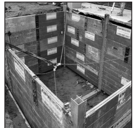
Configuration ClearSpan™ avec les poteaux de coin à pleine longueur
