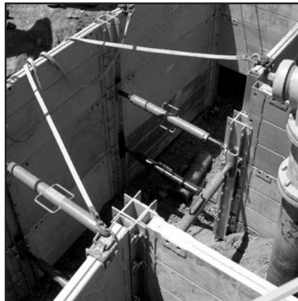
Configuration à trois côtés en « T » avec des supports ajustable et une combinaison de poteaux en « T » et de poteaux à 4 directions
